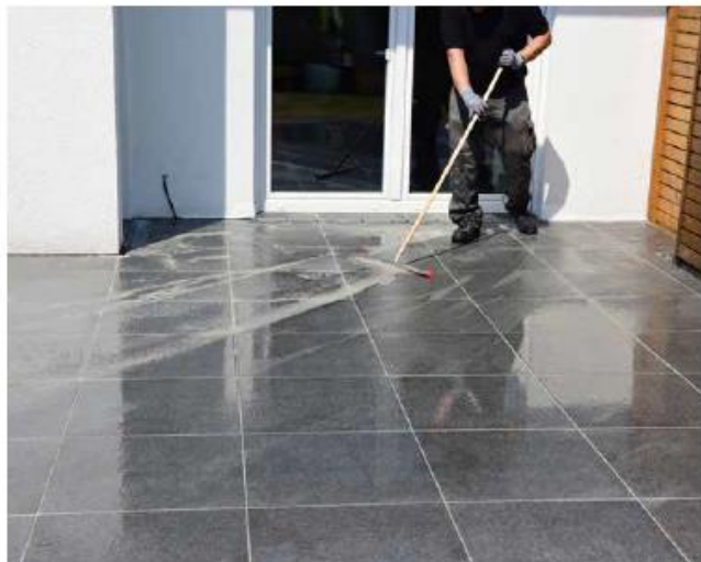
15 Nadmiar zaprawy fugowej usunąć ...
