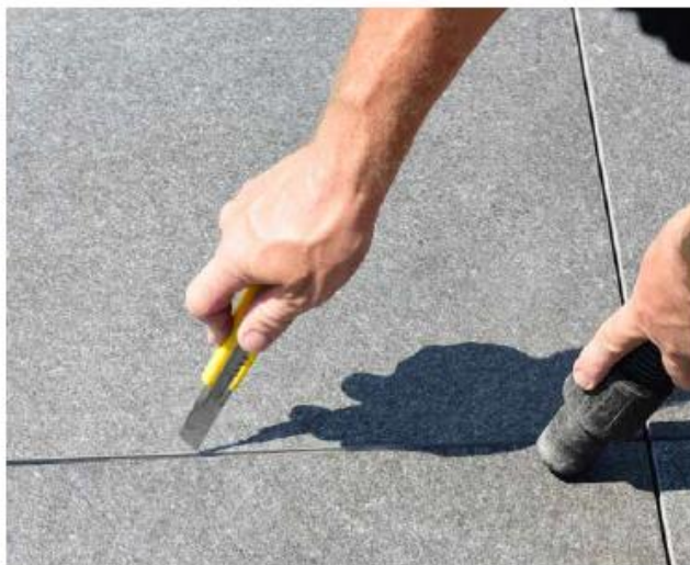
8 Szczeliny spoinowe dokładnie oczyścić i usunąć resztki zaprawy.
