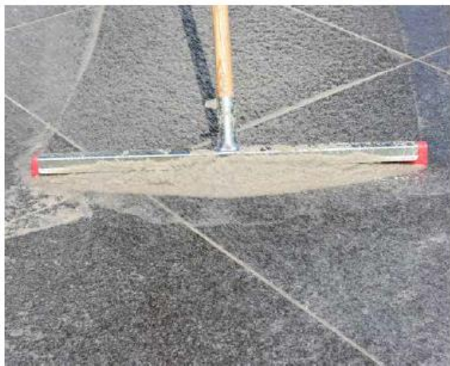
13 ... i przy pomocy gumowej raki wprowadzić w szczeliny spoinowe.
